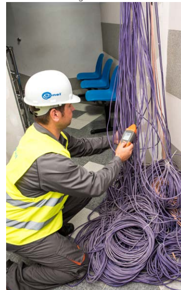
...und Zustand direkt vor der Verlegung
